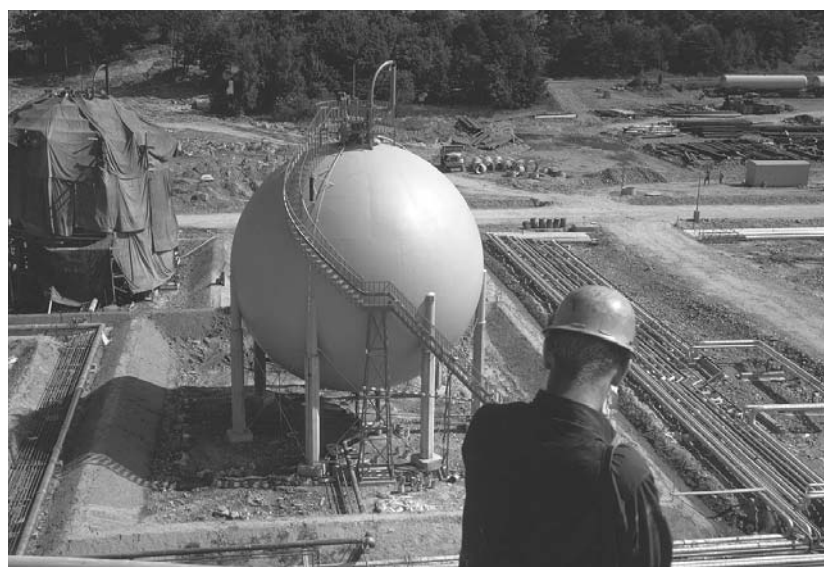
Bild från crackerbygget vid 1960-talets början. Crackern är industrikomplexets hjärta som levererar eten, propen och vätgas till de övriga industrierna via ett nätverk av pipelines. Crackern är igång dygnet runt och året runt. Foto Bohusläns museum.
