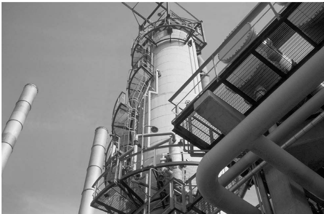
Bild från crackerbygget vid 1960-talets början. Foto Bohusläns museum.
